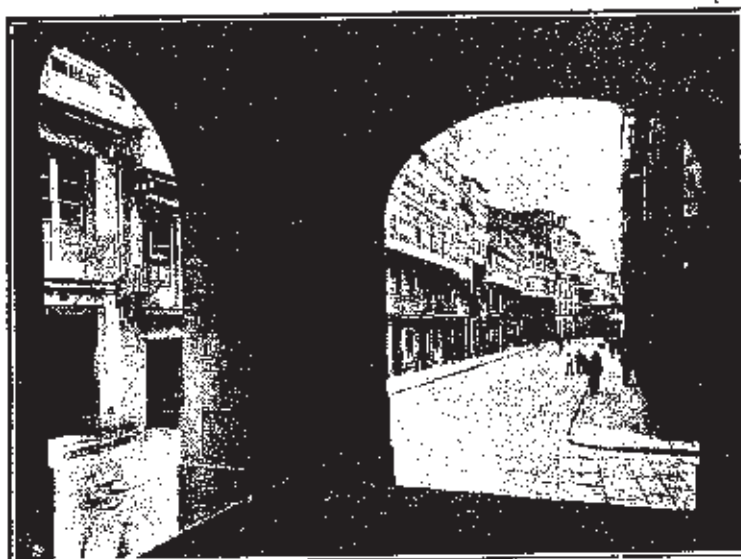
LA CORUÑA: Calle del Riego de Agua
