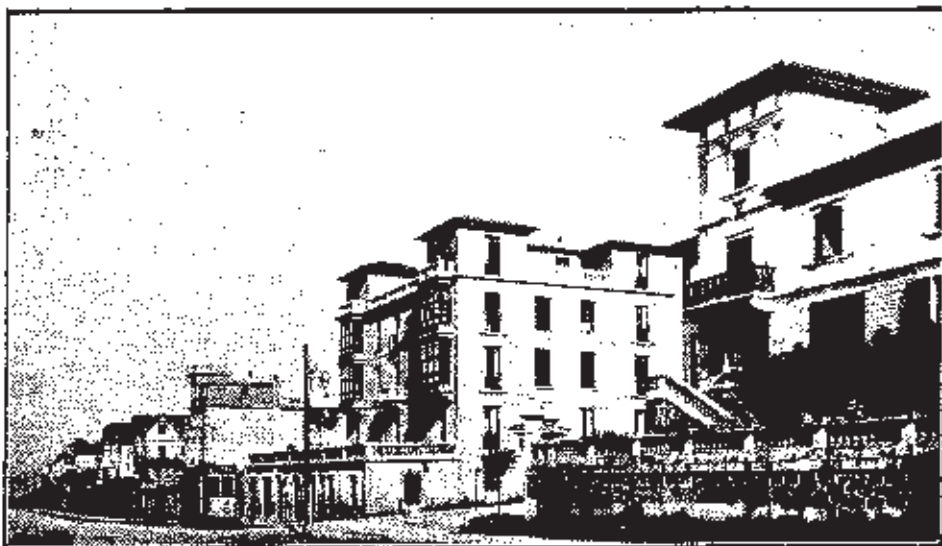
LA CORUÑA: Avenida de la Habana
