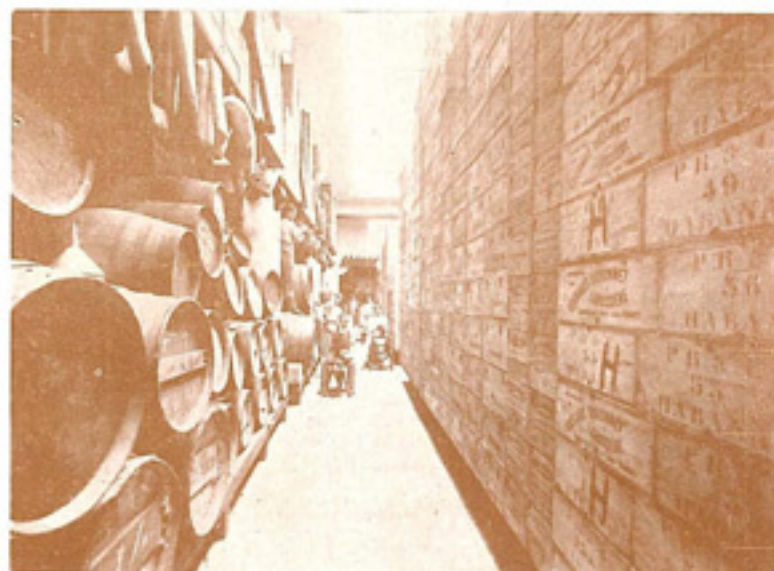
Departamento de vinos. Como este existen varios más en la casa de Pont, Restoy y Co.
