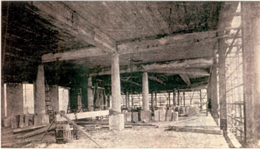
Suevia, nº 4, A Habana (29-II-1912). O Centro Galego en obras.
